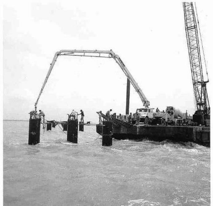
nen 125 apoyos, con separación de 31 m entre ejes, excepto en el claro de navegación (entre los apoyos 98 y 99) que tiene 48 m entre sus ejes. La altura libre en el claro de navegación es de 16 m. Cada tramo de la superestructura está formada por cuatro traveses prefabricados, pretensados en planta y postensados en obra después de colar la losa del piso.
