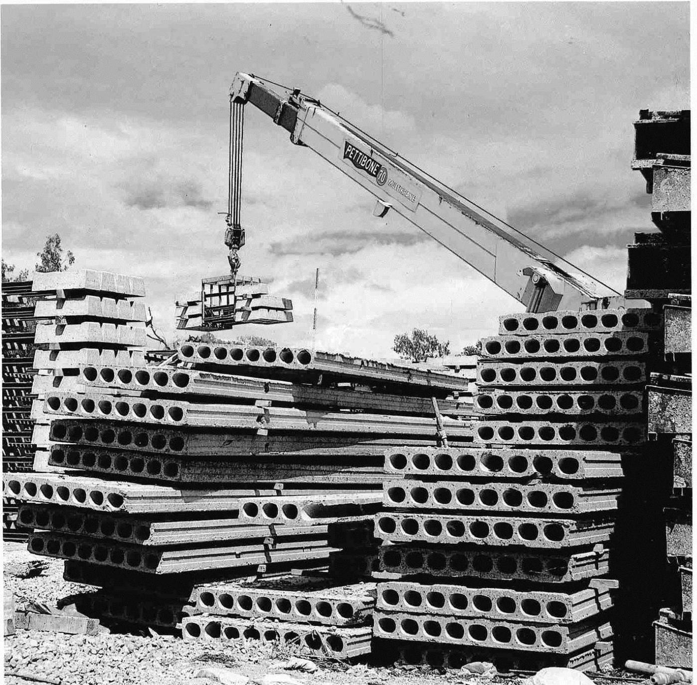
ra claros que van de los 4 a los 16 m con cargas de servicio que oscilan desde 150 kg/m<sup>2</sup> hasta 750 kg/m<sup>2</sup>.
