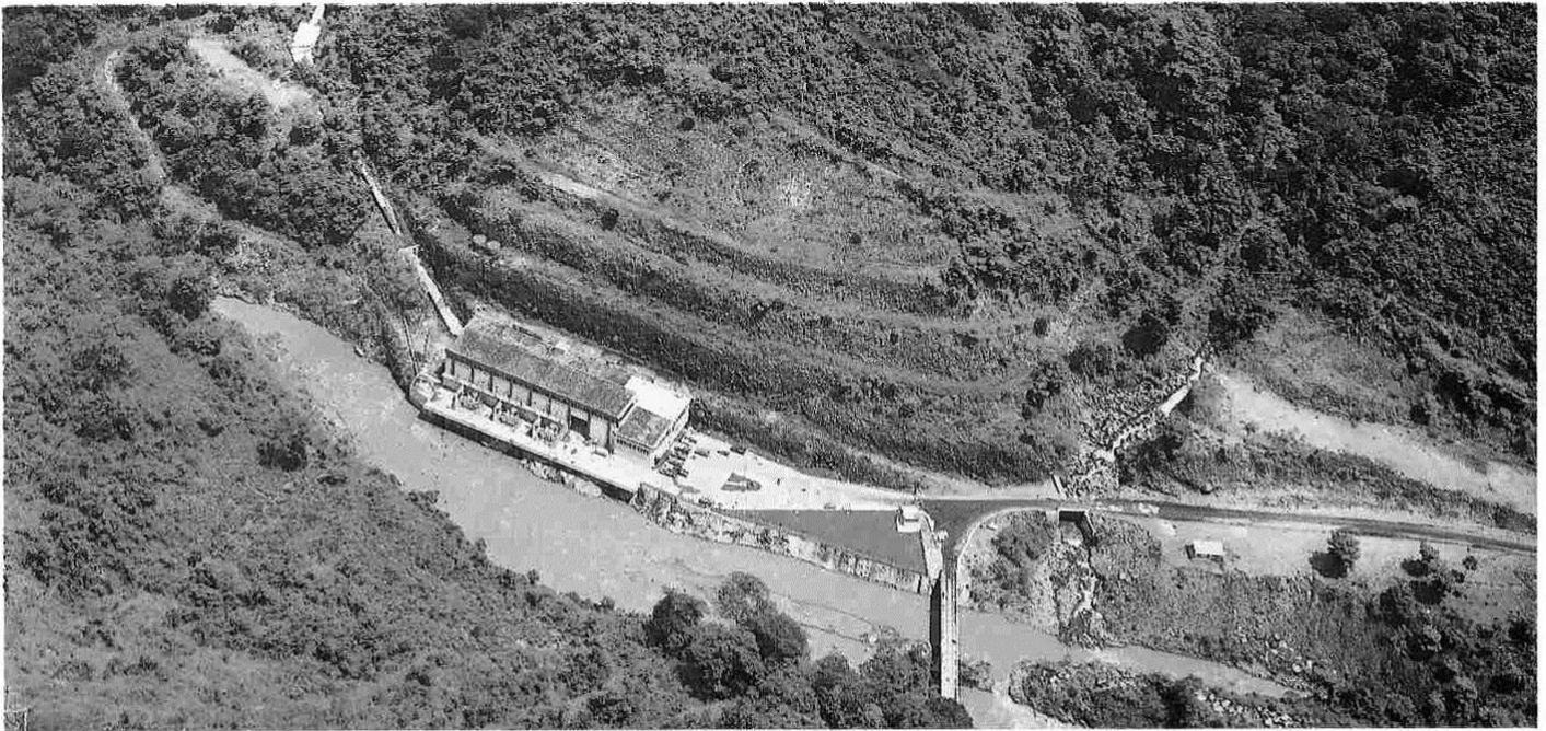
diámetro. Apoyada en bases de concreto, sigue la rama inclinada de 450 m y pendientes de 69%, cuya tubería va alojada en una estructura envolvente de concreto reforzado.
